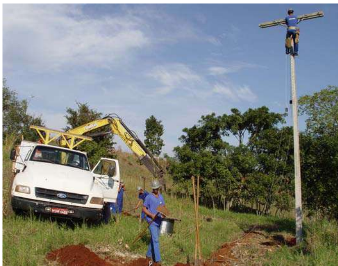
Figura 9.12 Turma da Santa Cruz na construção dos ramais em Taguaí – SP no Luz para Todos
