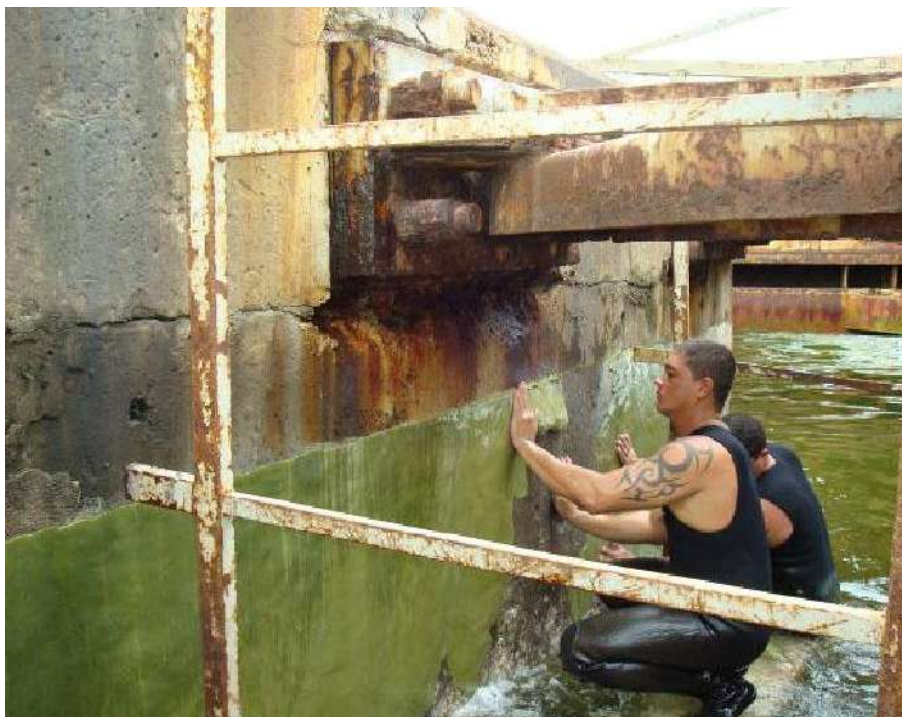
Figura 10.11 – Aplicação de resina epoxídica para proteção do concreto em porto . Foto vitserv.com.br
