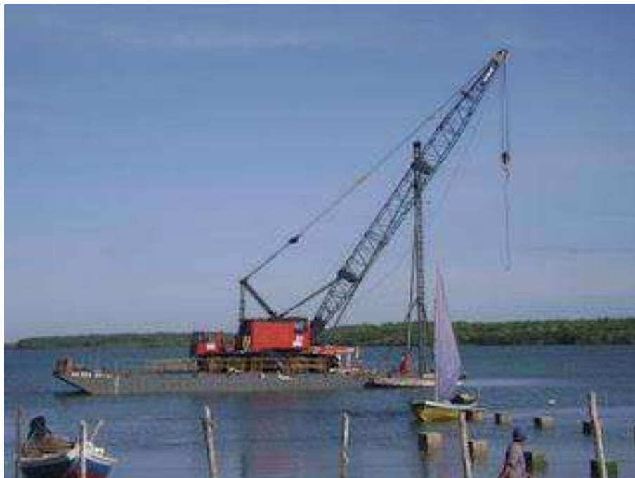
Figura 10.17 - Guindaste de 70 toneladas sobre balsa de 400 toneladas rumo ao cais.
