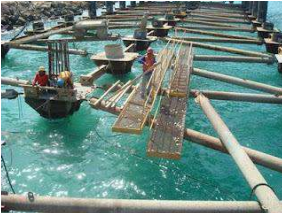
Figura 10.21 Na primeira etapa são lançados elementos pré-moldados longitudinais conexaodjibouti.blogspot.com
