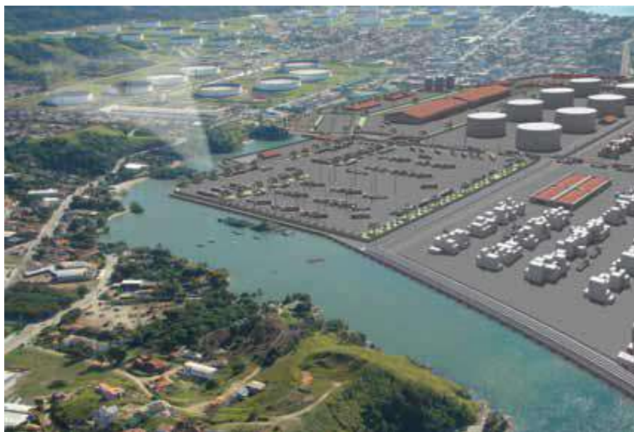
Figura 4.3 Vista do projeto de laje sobre pilotis sobre 75% da área da baía do Araçá (Foto EIA - RIMA CPEA).
