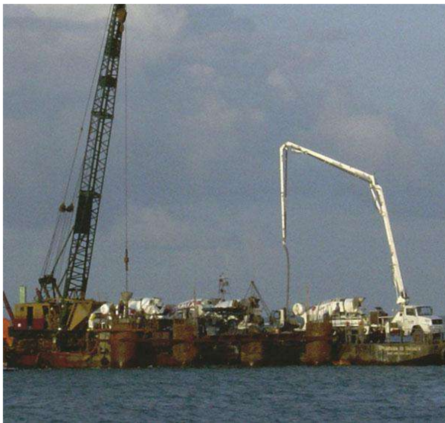
Figura 10.20 – Canteiro flutuante para estacas submersas. revistatechne.com.br
