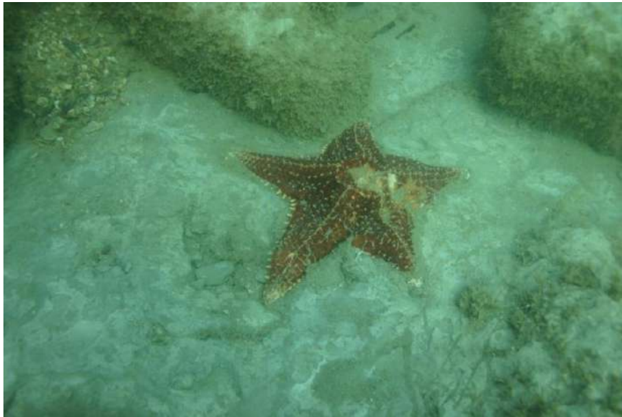
Figura 10.12 Estrela do mar concretada junto à base de pilar submersa.
