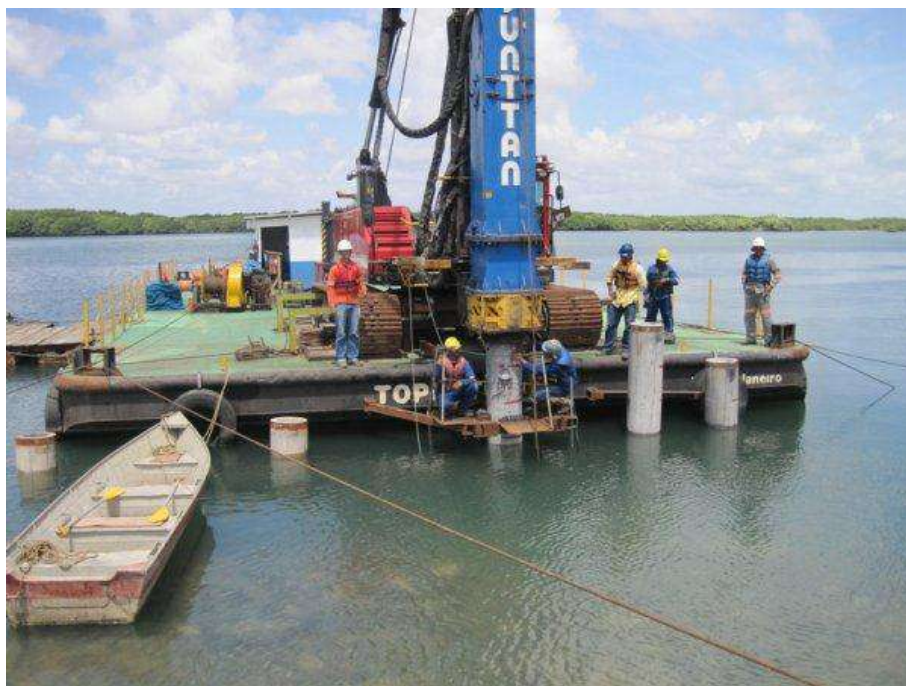
Figura 5.2 Obra de cravação de estacas em região costeira www.sudestenavegacao.com.br
