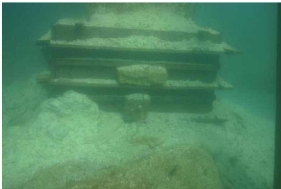
Figura 10.14 – Formas de madeira deixadas no local após a conclusão da obra.
