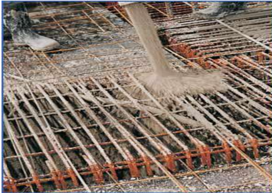
Figura 10.23 Concretagem da união entre lajes e vigas com concreto auto adensável
