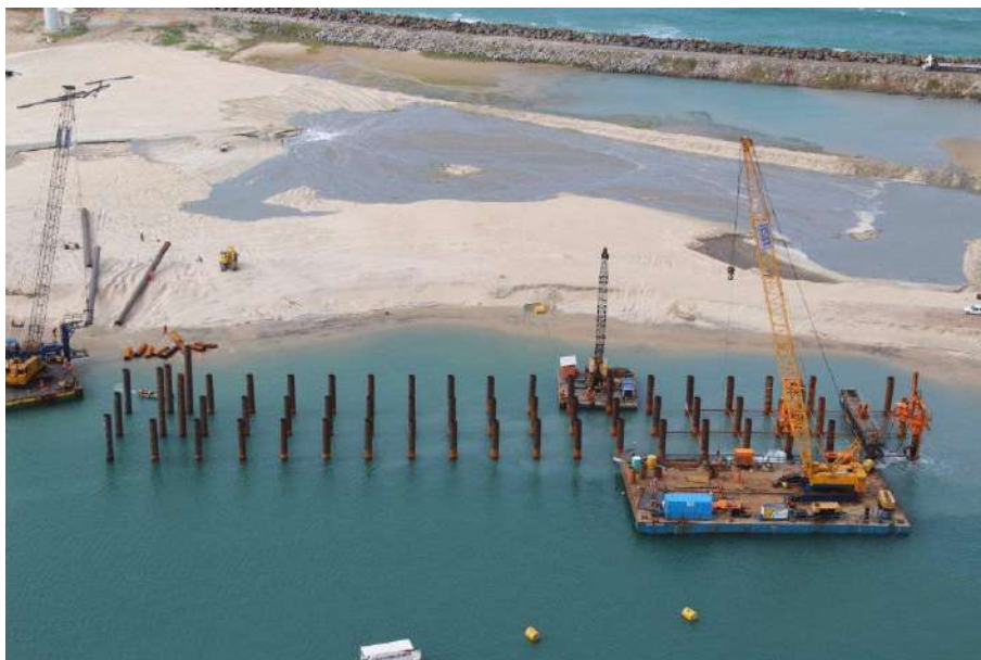
Figura 10.19 - A obra com duas frentes de serviço: a cravação das estacas constremac.com.br
