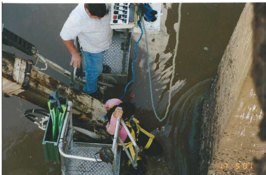
Figura 10.7 - Dificuldade de acesso inspeção em ponte da Rod. Presidente Dutra
