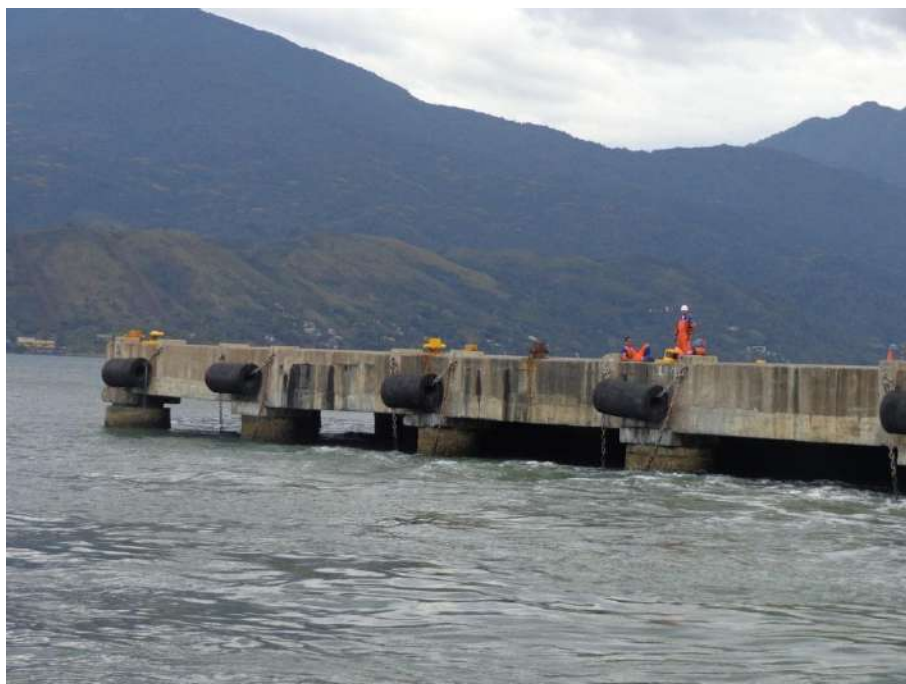
Figura 5.3 Vista da estrutura do píer do porto de São Sebastião com pilares de cerca de 1,20m de diâmetro.
