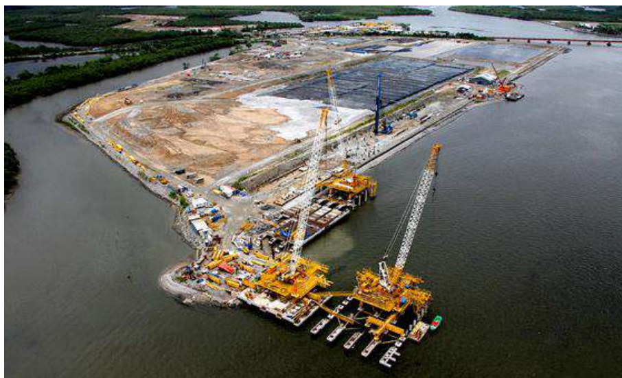
Figura 10.10 - Canteiro de obras em área costeira - Site da foto grandesconstrucoes.com.br – Porto de Santos
