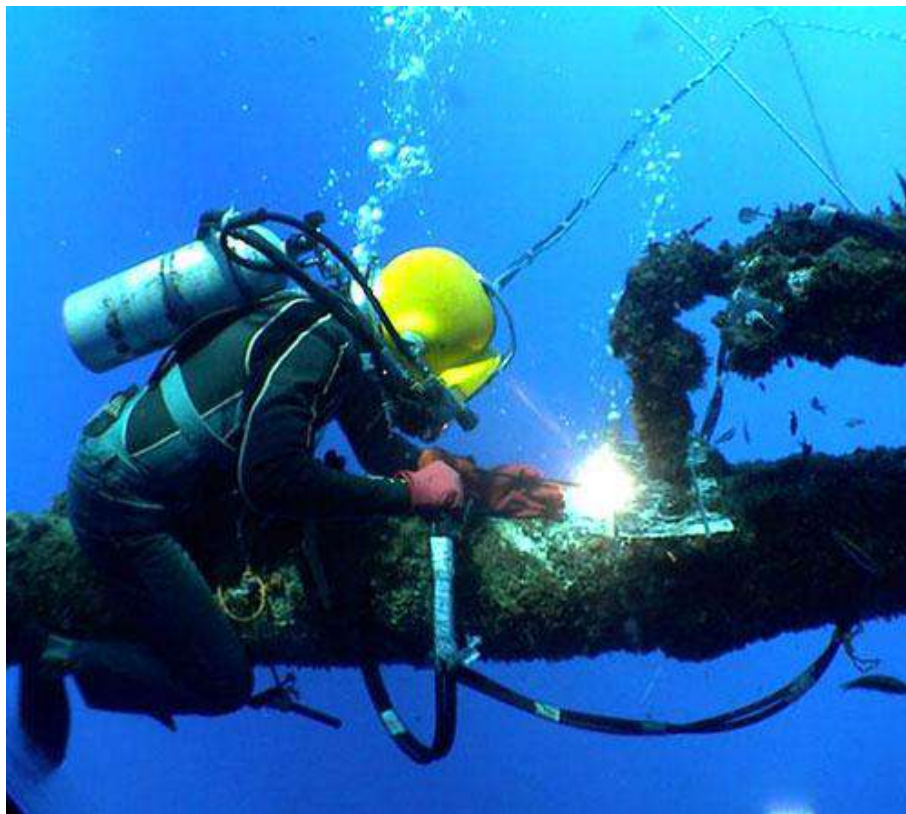
Figura 10.4 Condições restritas de mobilidade na execução de obras submersas - www.portalnippon.com
