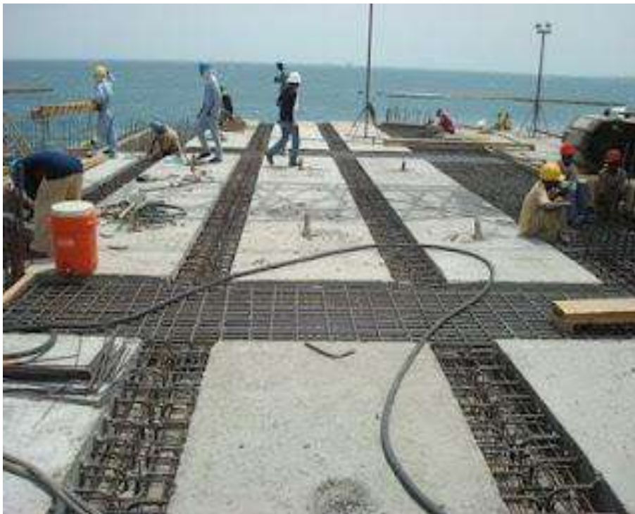
Figura 10.22 Concretagem dos encontros de lajes com vigas de apoio - Site da foto conexaodjibouti.blogspot.com
