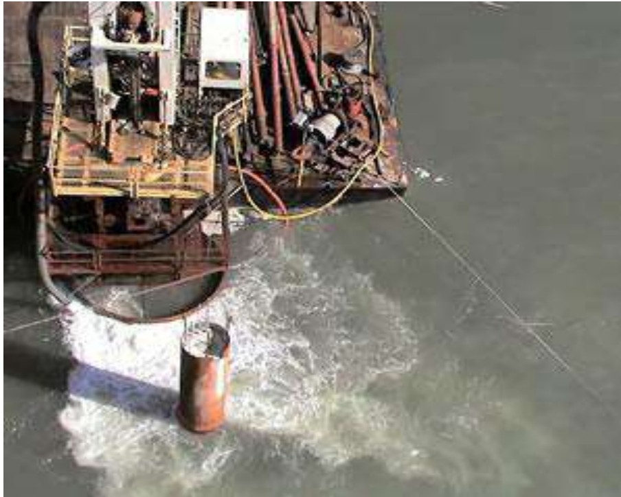
Figura 10.18 - Estacas submersas moldadas in loco - constremac.com.br
