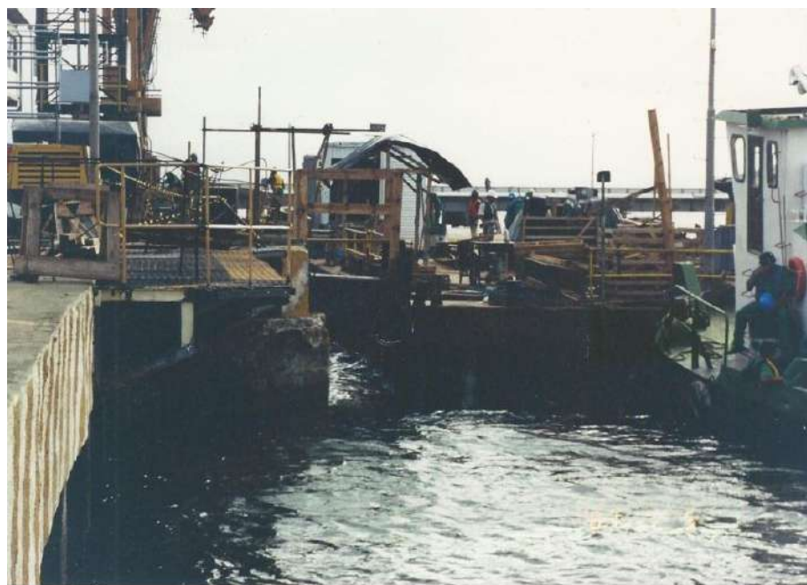
Figura 10.8 - Canteiro de obras com alojamento obra de recuperação no porto de Paranaguá agosto de 2008.
