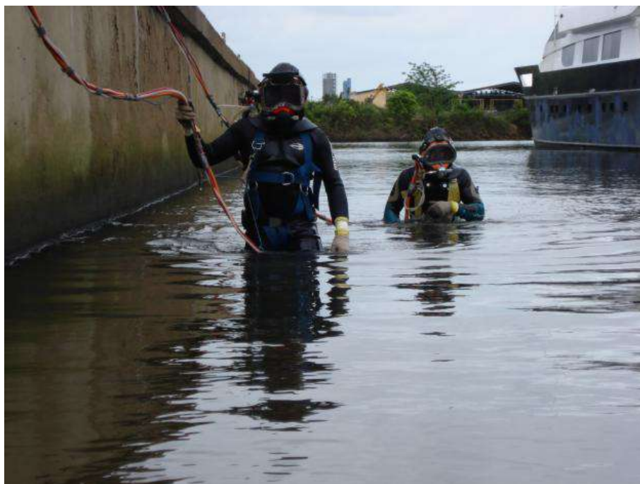
Figura 10.9 - Mergulhadores apoiados em plataforma submersa em obra de recuperação de pilares no porto de Paranaguá em 2008.
