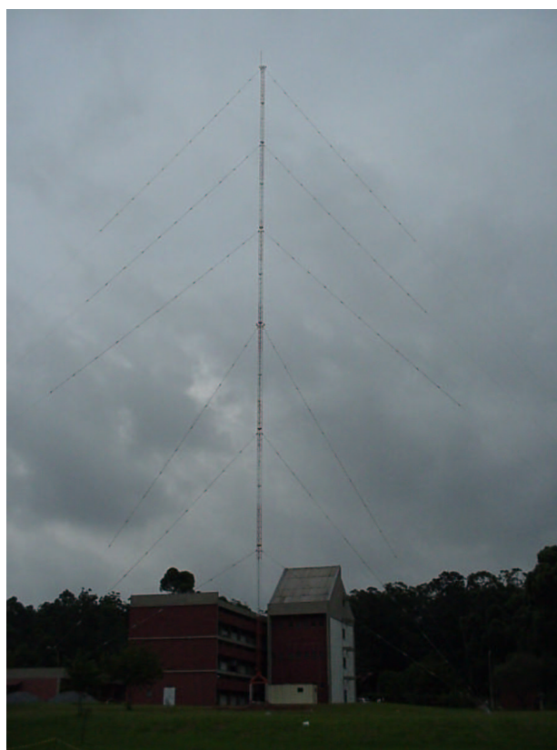
FIGURA 2 – TORRE ESTAIADA COM 62,5 m DE ALTURA.
