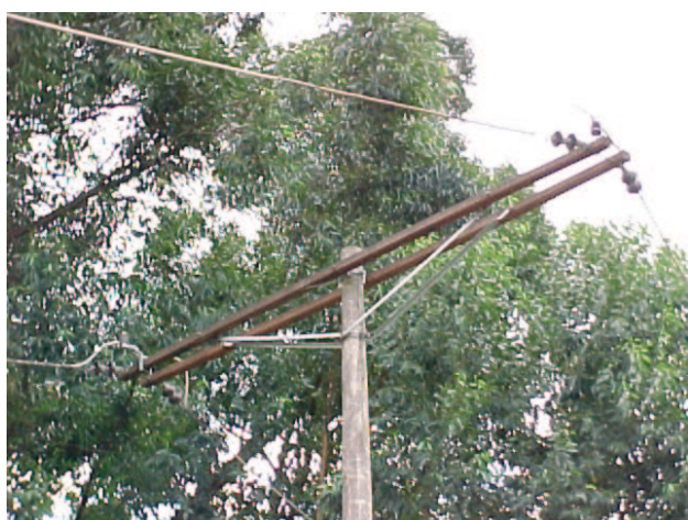
FIGURA 6 – CRUZETA SEPARANDO AS LINHAS COM E SEM PÁRA-RAIOS.
