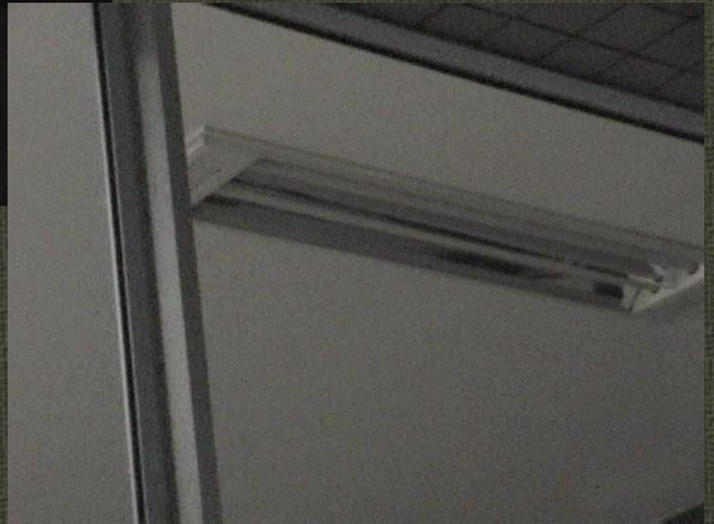
Figura – Sistema 32WT8, refletor especular. Foto de agência bancária, em SP, setor caixa automático. Fonte: Foto do Autor.
