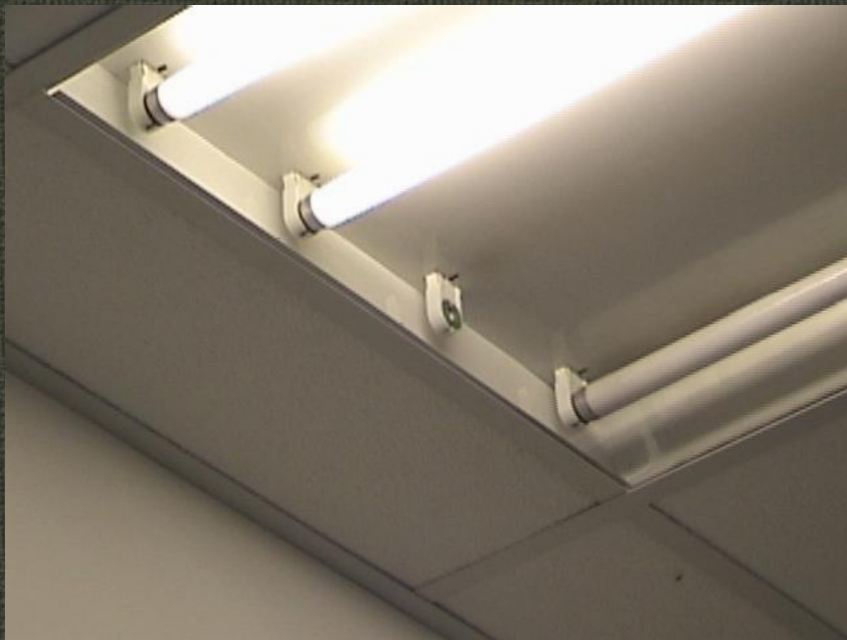
Figura – Sistema (4x)32WT8 e refletor com pintura branca (placa difusora, em plástico, removida), em detalhe o porta lâmpadas tipo com rotor de segurança. Foto no IEE/USP, “lab. (antigo) de geladeiras”. Fonte: Foto do Autor.
