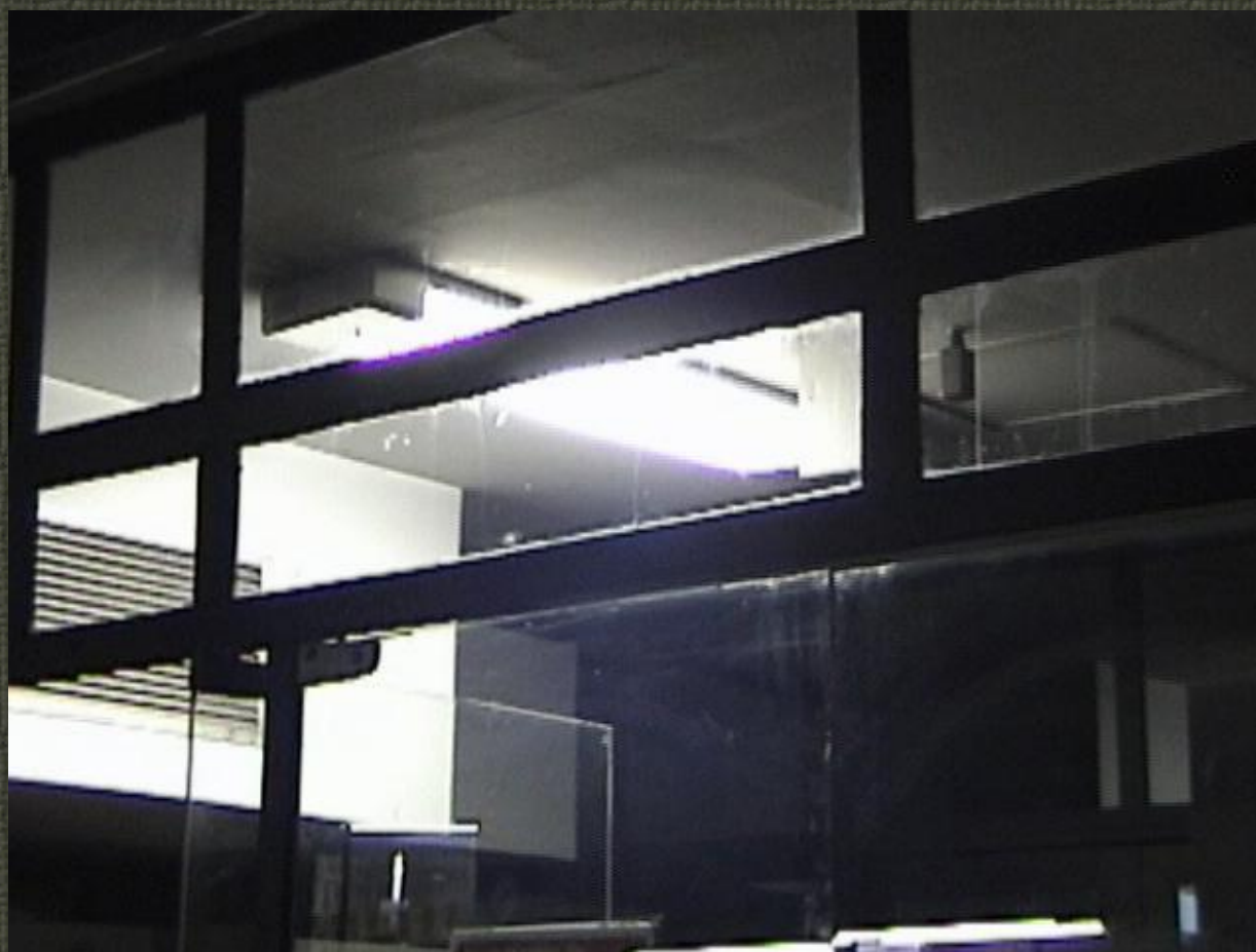
Figura – Sistema (4x)40WT12, sem refletor. Foto de agência bancária, em SP, setor caixa automático. Fonte: Foto do Autor.
