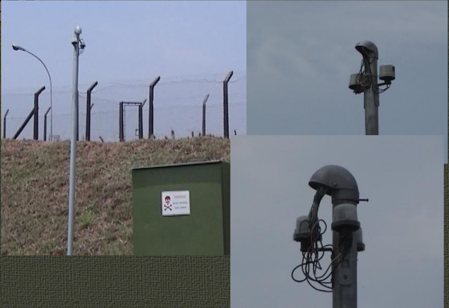
Figura – Relé fotoelétrico utilizados para o controle de iluminação artificial no Campus da USP.
