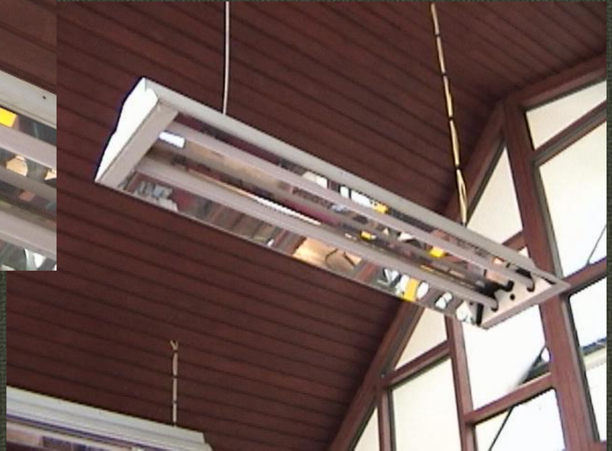
Figura – Sistema 32WT8 e refletor em vidro com espelho (posterior). Foto no IEE/USP, “Tab. 3 de instalações”. Fonte: Foto do Autor. 82
