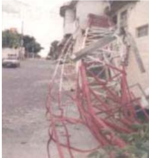
Figura 21 - Torre de telefonia caída em 25/11/2002, no bairro Filadélfia, em Betim, MG. Fonte: Jornal Estado de MG, n.º 22.249, 27/11/2002, Caderno Gerais.
