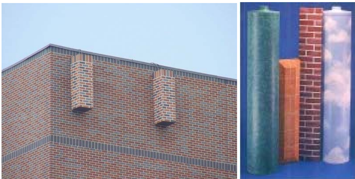
Fig. 6 - Detalhe de radome em prédio de Los Angeles e outras pinturas em radome. Fonte: Kramer.Firm's Wireless Site Gallery - < http://www.kramerfirm.com/cells/index.php >
