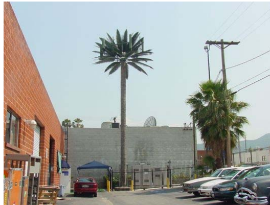
Fig. 8 Estação imitando palmeira (junto a uma rodovia no Sul da Califórnia - Los Angeles ) Fonte: Kramer.Firm's Wireless Site Gallery - < http://www.kramerfirm.com/cells/index.php >
