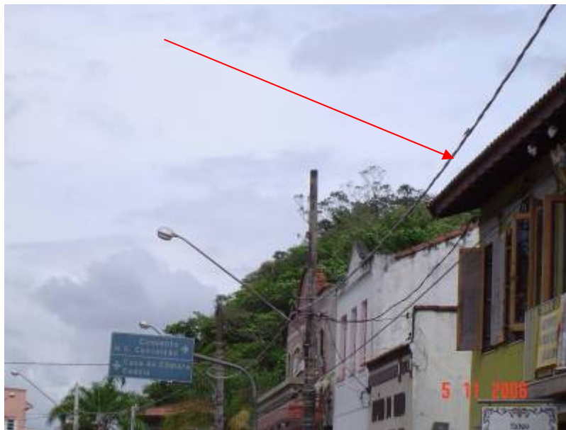
Figura 16: Foto de rede secundária de distribuição com fios pré-reunidos ou multiplexada
