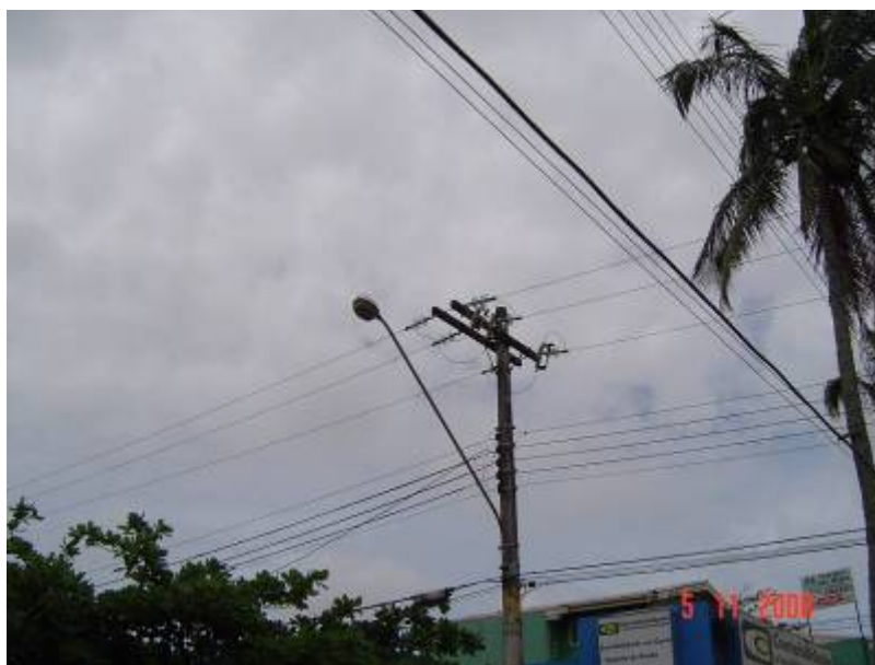
Figura 15: Foto de uma rede secundária de distribuição convencional
