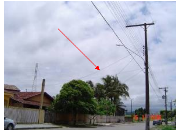
Figura 20: Foto de uma entrada de serviço de consumidor em baixa tensão em região pouco arborizada
