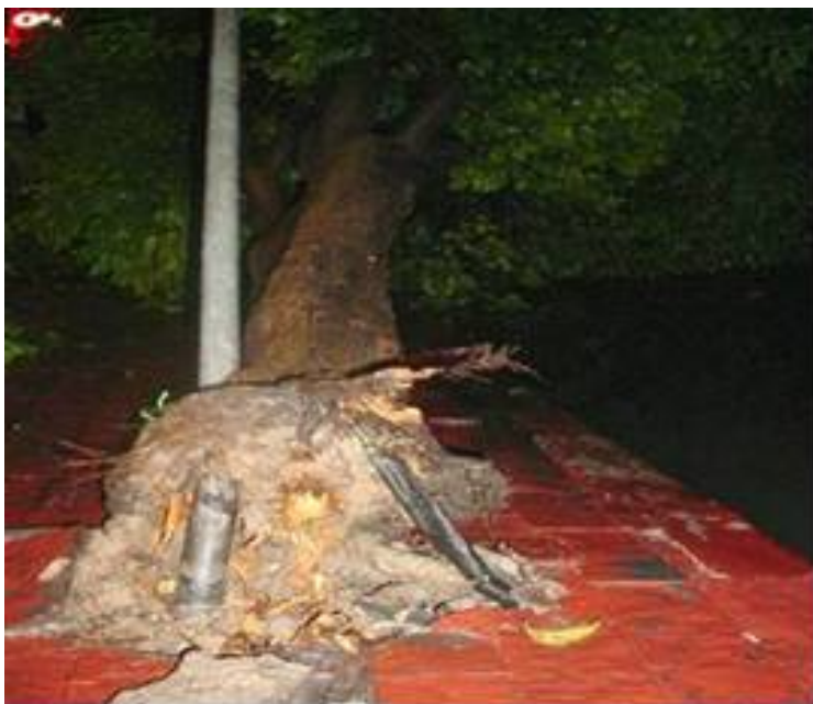
Figura 30: Árvore com aparência saudável, mas a base do tronco estava recoberta por cimento sem nenhum espaço permeável. Tinha como sustentação um poste de sinalização de trânsito. Com a chuva e o vento forte o peso da copa aumentou e a árvore veio a cair, desligando a rede secundária.
