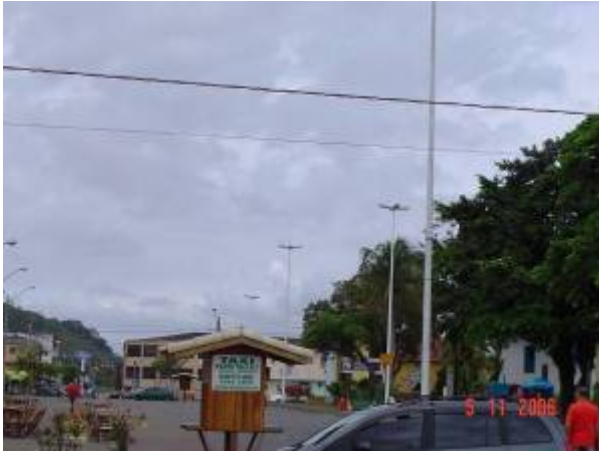
Figura 22: Foto de iluminação pública ornamental em praças com baixa densidade de vegetação, na qual se utilizam torres metálicas com luminárias em pétalas.
