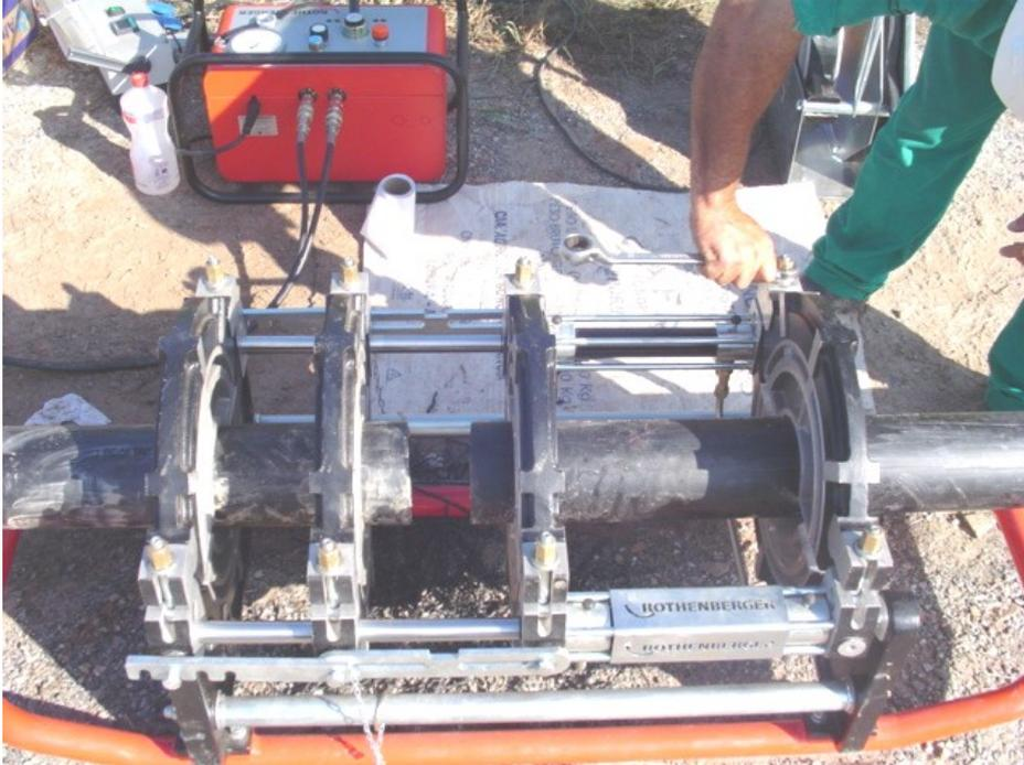
**Figura 46 Vista de posicionamento de tubulação PEAD para soldagem.**
