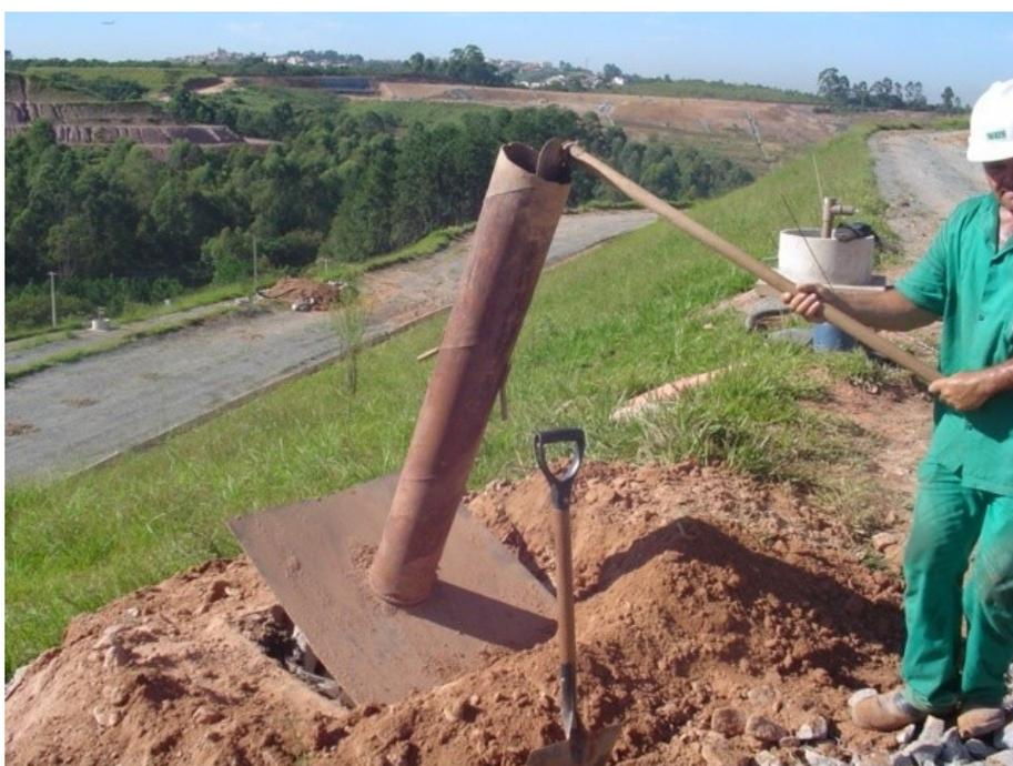
**Figura 64 Vista de Encerramento de fogo em Dreno Vertical por abafamento.**
