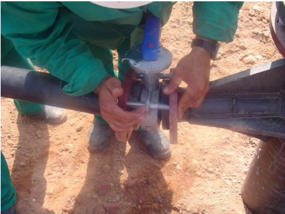
**Figura 52 Vista instalação de válvula.**
