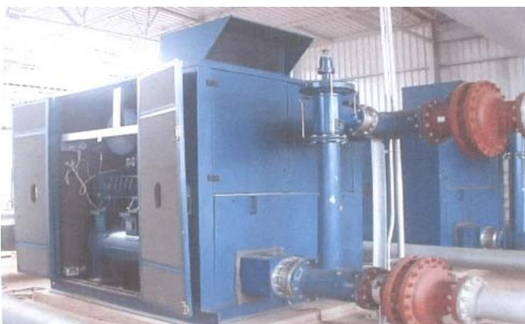
**Figura 33 Vista de Blower utilizado no aterro sanitário Bandeirantes**
