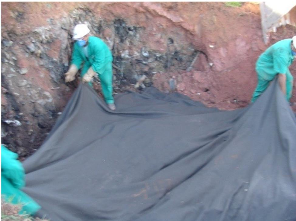
**Figura 69 Vista de instalação de Manta Geotextil.**
