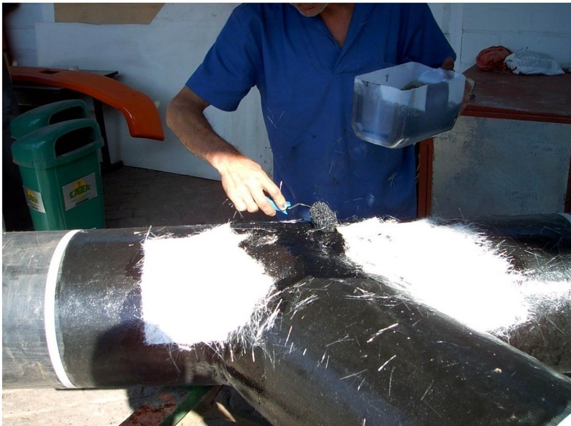
**Figura 54** Vista de execução do revestimento de Tê.
