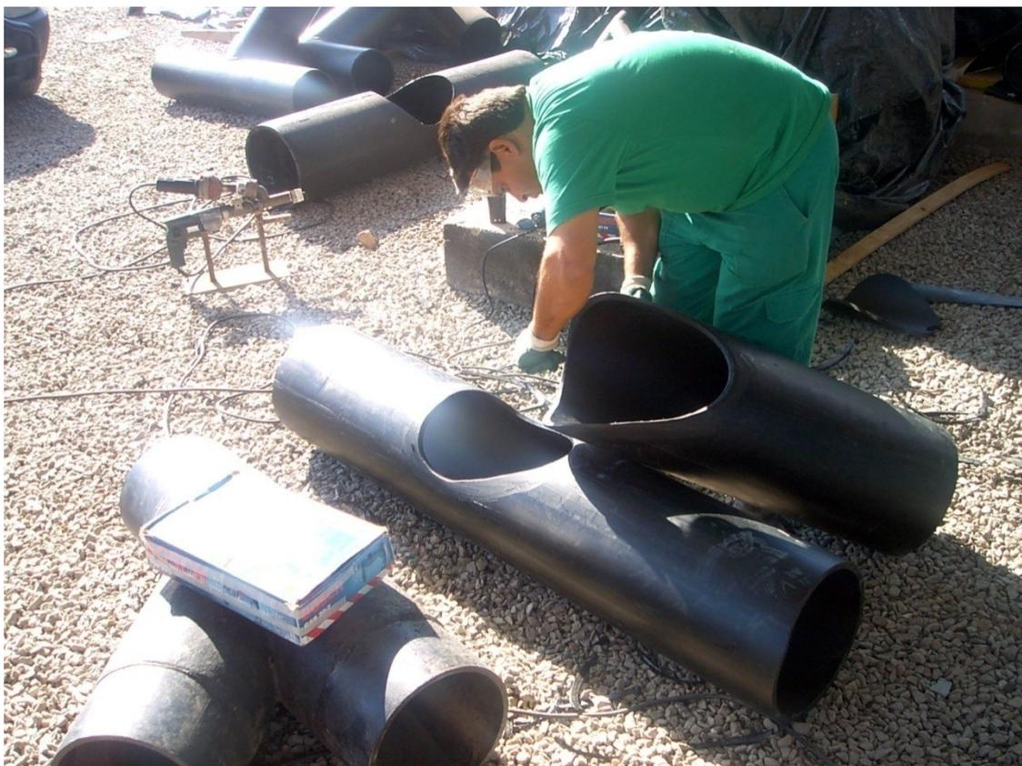
**Figura 53** Vista de corte de tubo para execução de Tê.
