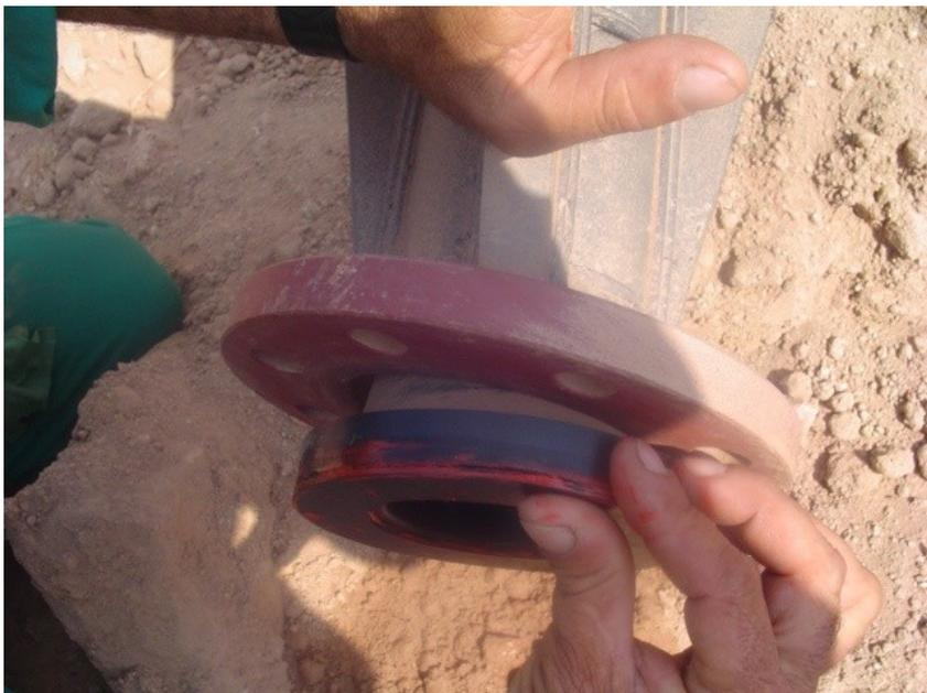
**Figura 51 Vista instalação de junta em borracha EPDM**
