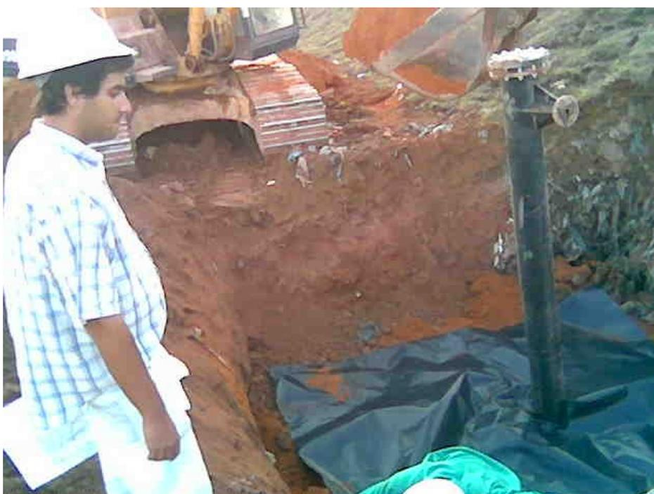
**Figura 71** Vista de instalação de Manta PEAD em talude.
