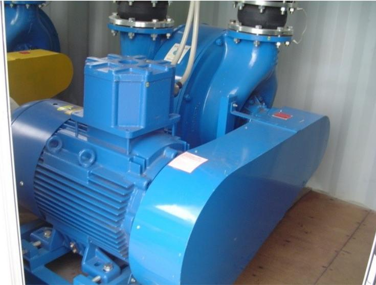
**Figura 34 Vista de Blower utilizado no aterro sanitário CDR-Pedreira**
