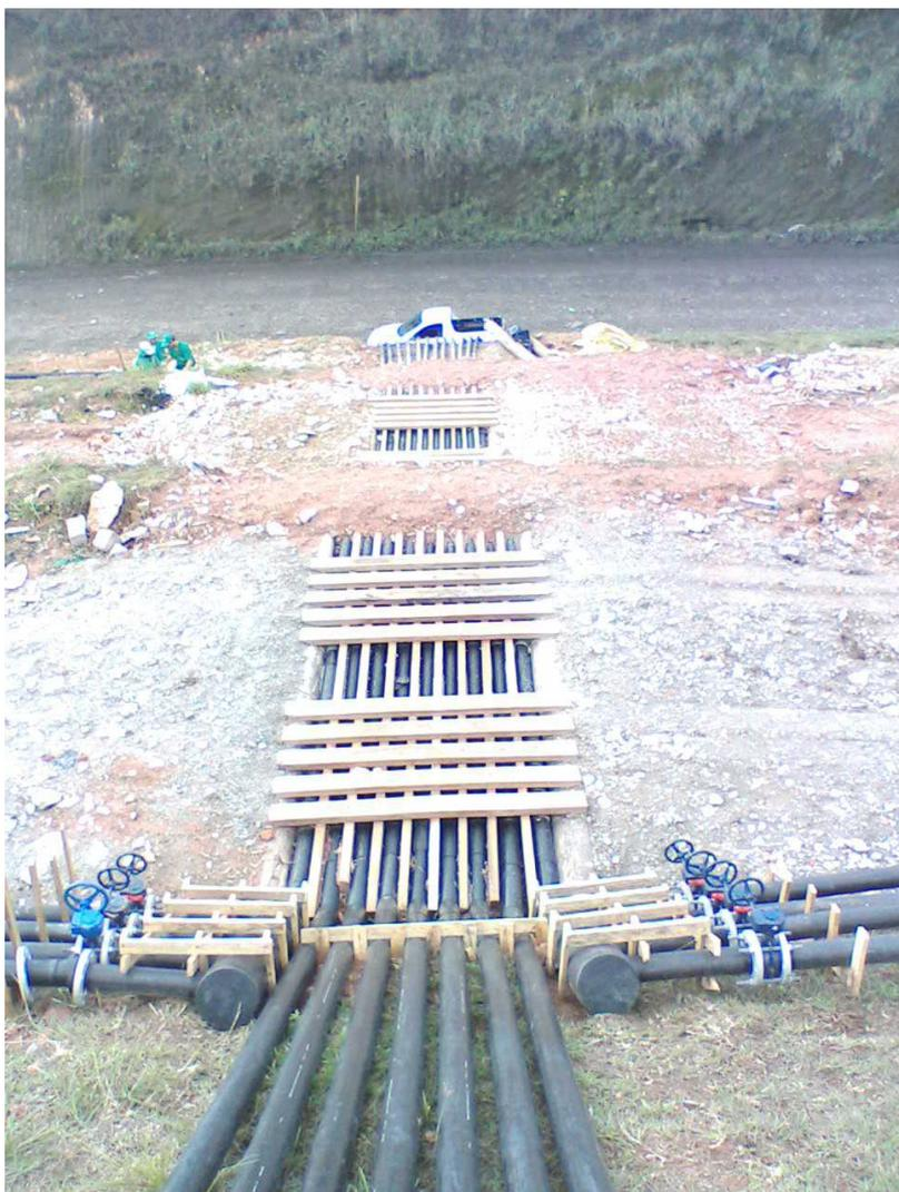
**Figura 55 Vista de execução Travessia Exposta.**
