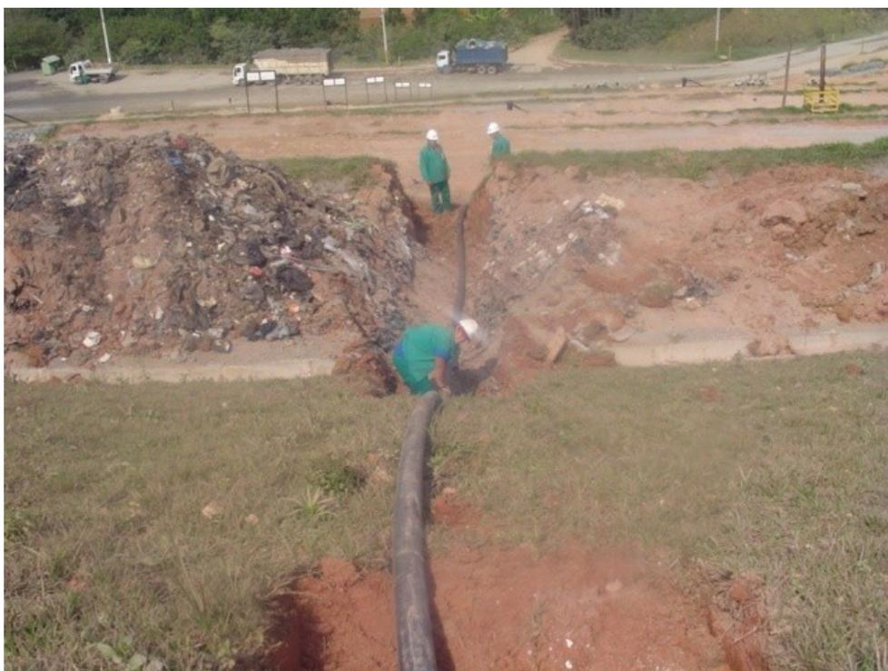
**Figura 56 Vista de execução Travessia sem encamisamento.**
