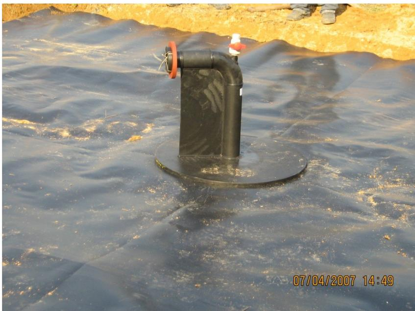
**Figura 75 Vista de instalação de cabeçote no Aterro Sanitário Terrestre.**
