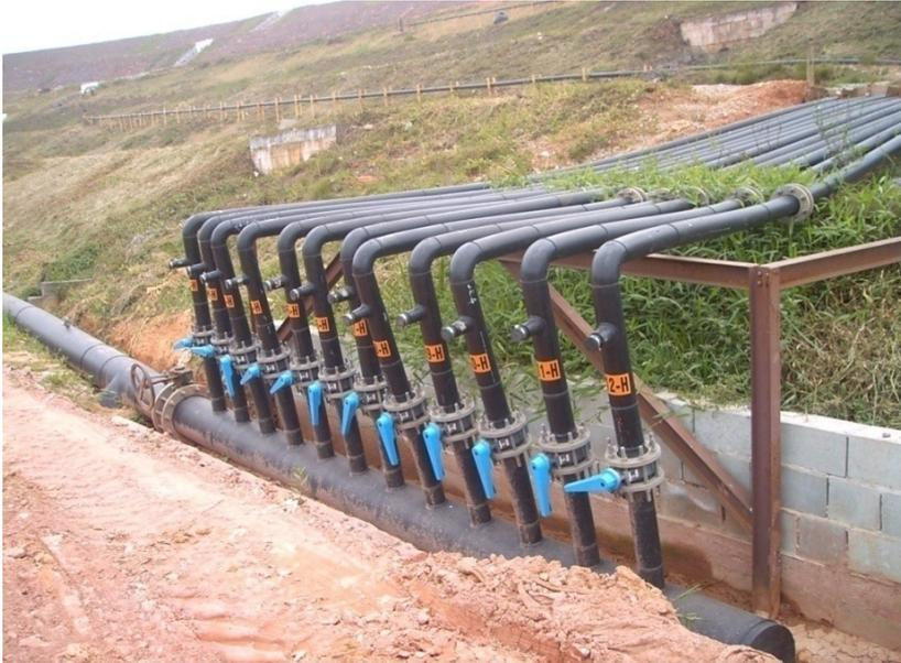
**Figura 39** Vista de Manifold utilizado no aterro sanitário Lara.
