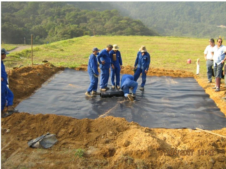
**Figura 72 Vista de instalação de Manta PEAD em platô no Aterro Terrestre.**
