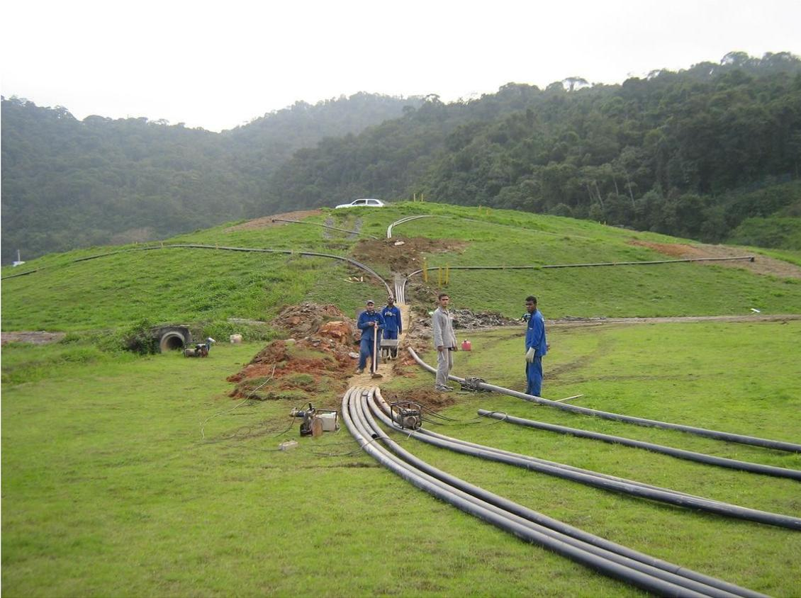
**Figura 44 Vista de implantação de linhas de Biogás no Aterro Sanitário Terrestre**
