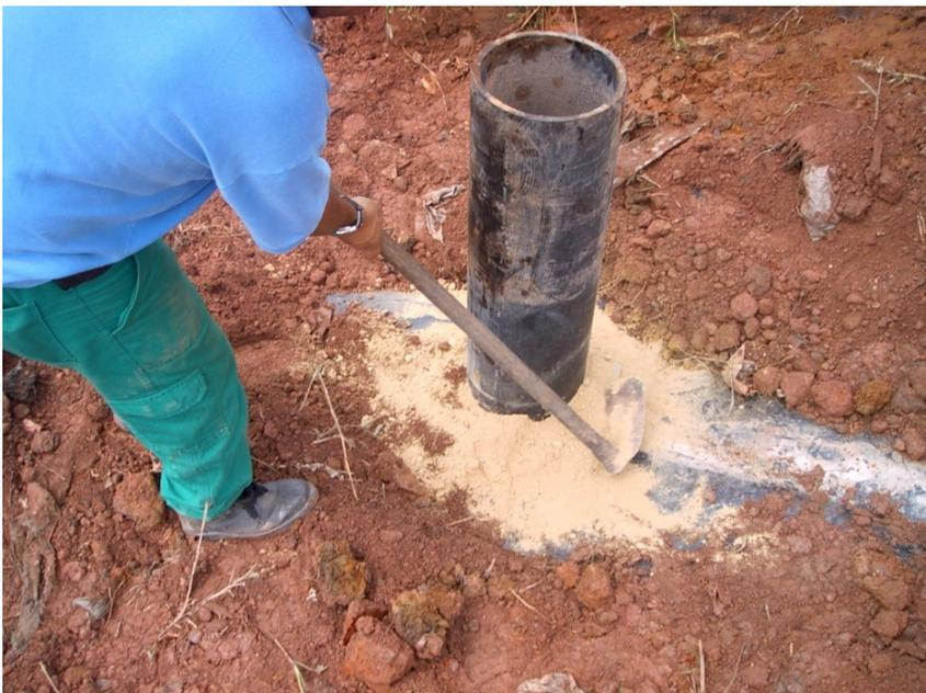
**Figura 73 Vista de execução de selo com bentonita.**
