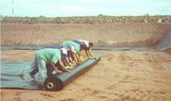
**Figura 4 Instalação de manta de impermeabilização.**
