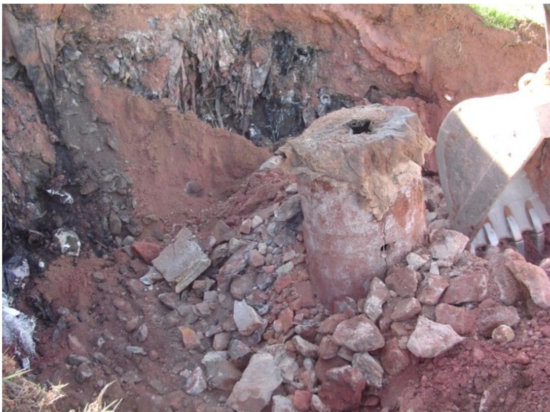
**Figura 68** Vista de escavação de dreno vertical.
