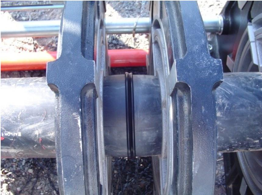
**Figura 50 Vista tubulação após soldada**
