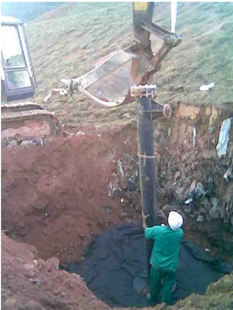
**Figura 76** Vista de instalação de cabeçote no Aterro Sanitário CDR-Pedreira.
