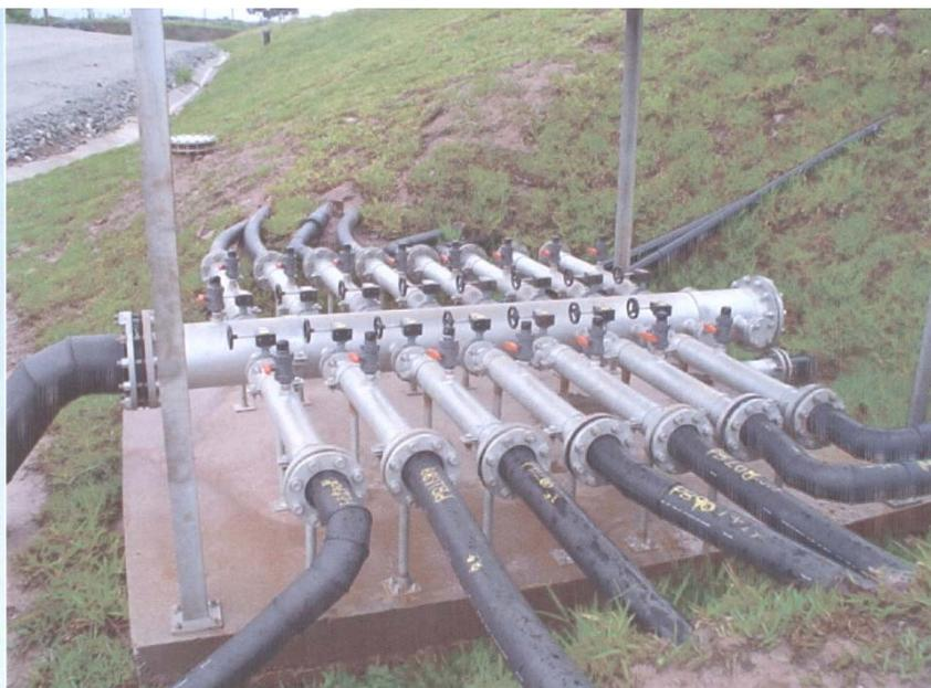
**Figura 41 Vista de Manifold utilizado no aterro sanitário Bandeirantes.**
