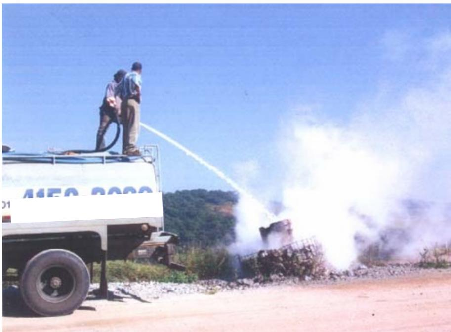
**Figura 63 Vista de Encerramento de fogo em Dreno Vertical por água.**
