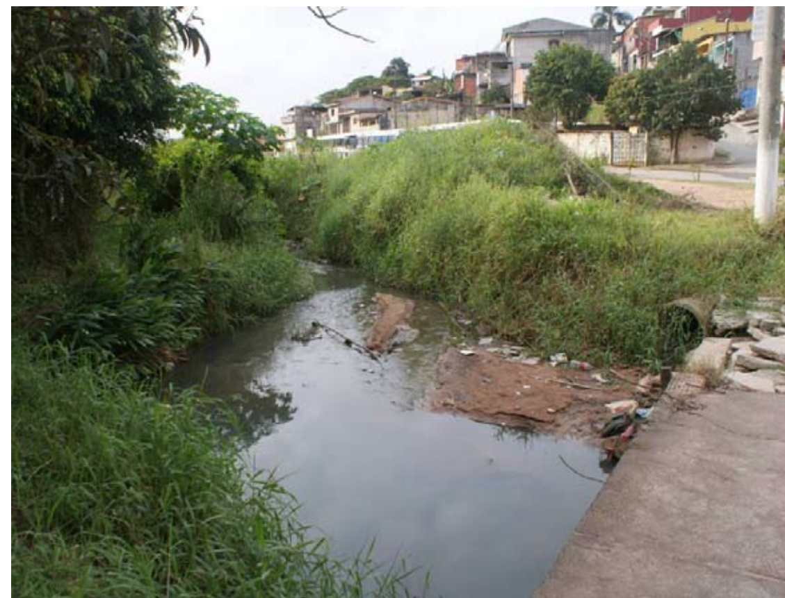
Curso d'água no Bairro Tomé com descarga de esgoto doméstico.
