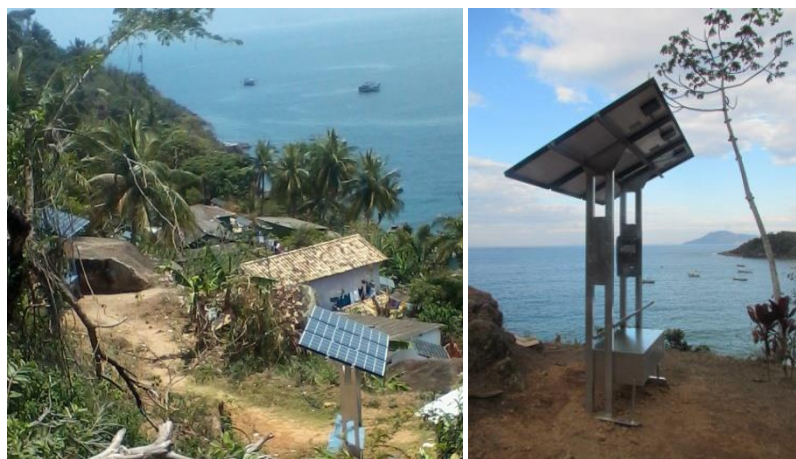
Figuras 1 e 2: Sistemas fotovoltaicos instalados nas comunidades de Ilhabela
