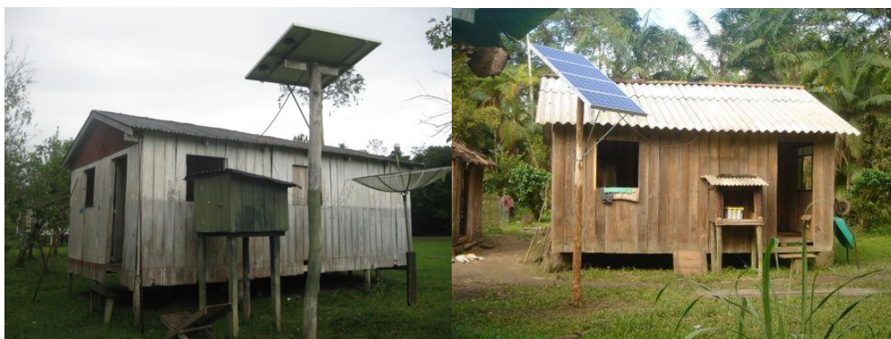
Figura 4 – Abrigo de baterias pertencentes aos SFDs instalados em Aiucá (esquerda) e Varadouro (direita) Foto: Arquivo gráfico do LSF-IEE-USP
